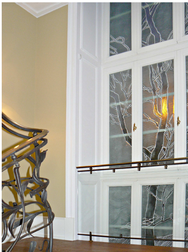
Spocznik klatki schodowej - kuta barierka z motywem liści - okno z witrażem fusion, który daje uczucie prywatności
