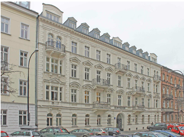
Warszawa Wniejska 19 "Edipresse" - elewacja frontowa
